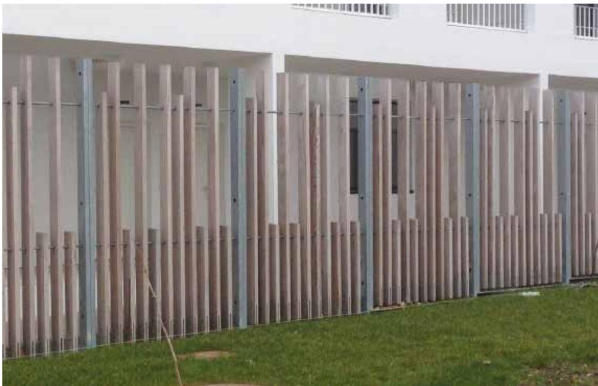
Ossature poteaux et cadre acier galvanisé
