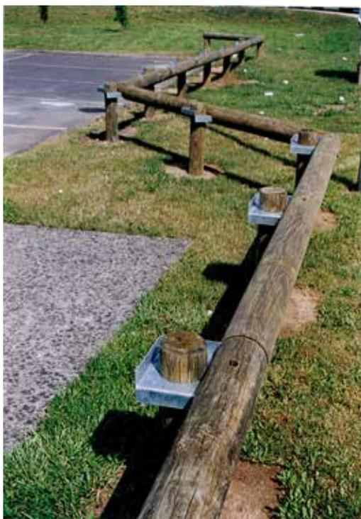
Poteaux diamètre 140 et lisses diamètre 160
